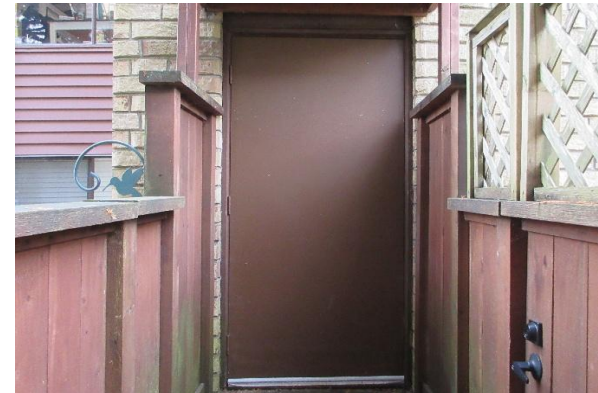
Metal egress door
